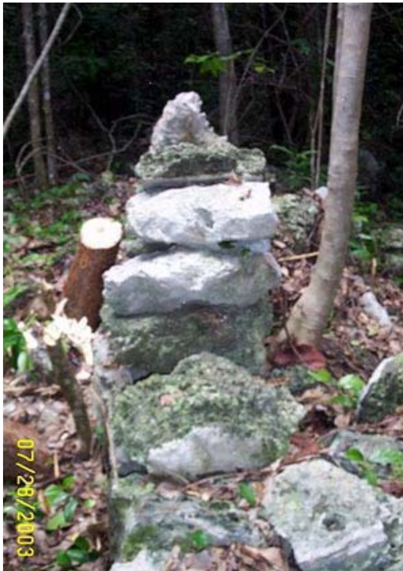
Figura 8. Muro de piedra simple (albarrada) formado por una única línea de grandes piedras puestas sin mortero.
